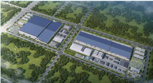
陕西省西安市渭北经开区光伏新能源产业园
